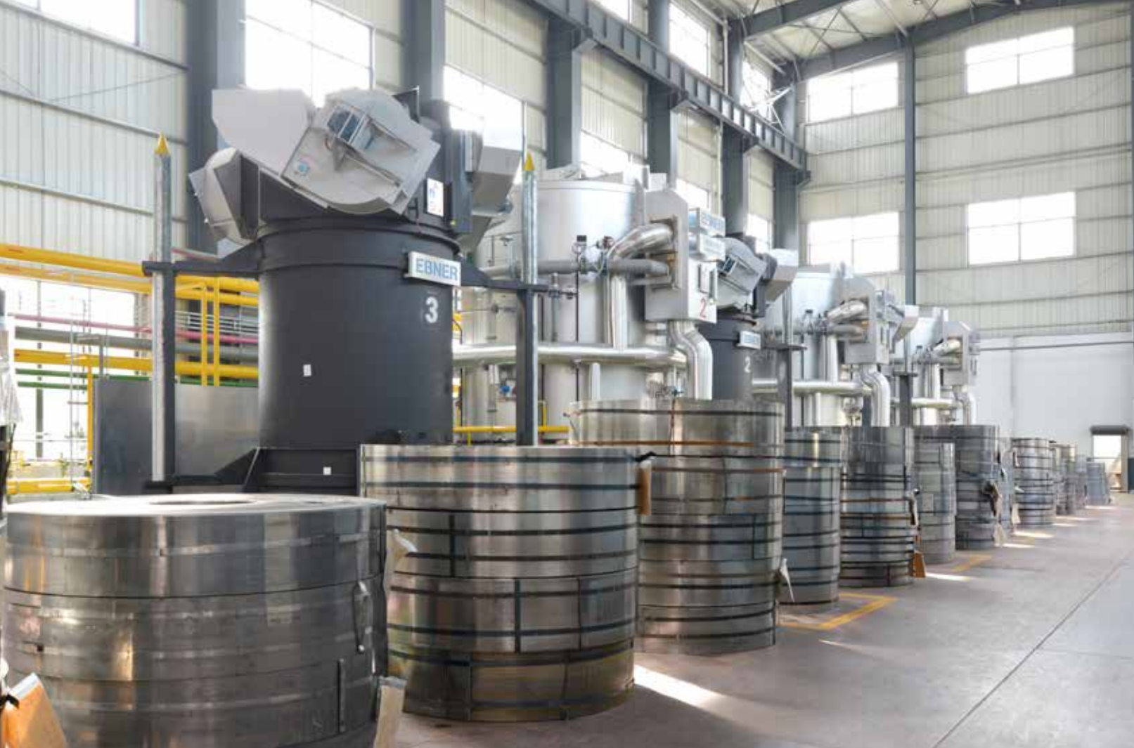
Die Anlage bei Zhejiang Rongxin
